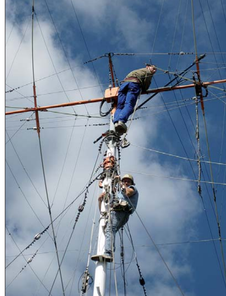
Rainer, DL1AUZ (oben), und Andre, DL4UNY, reparieren die Ilmenauer 4-Element-Dreiband-Quad.
